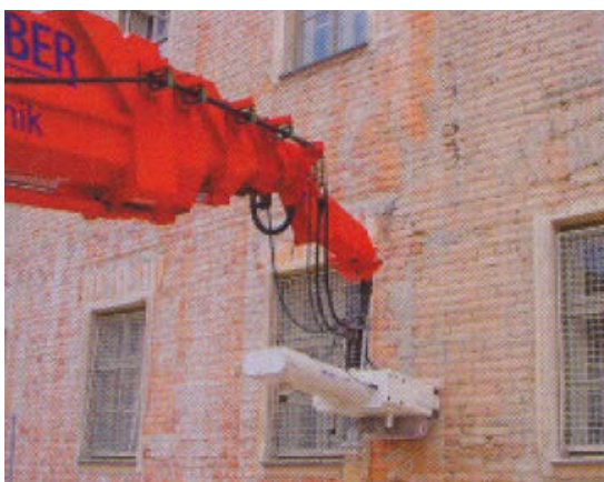
Foto: Fresa en funcionamiento
