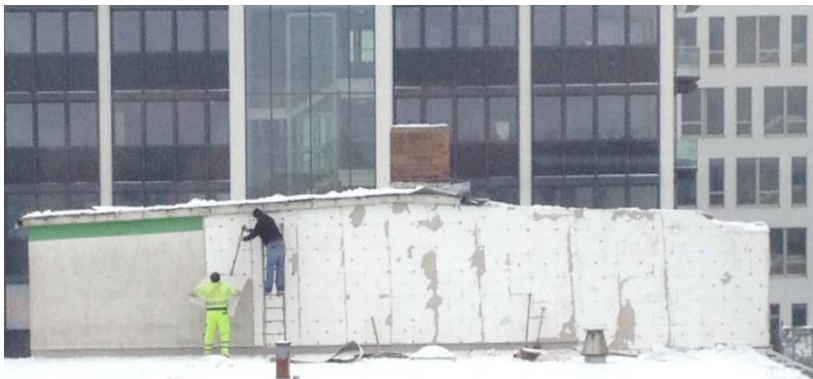
Fotos: Deconstrucción de un SATE
