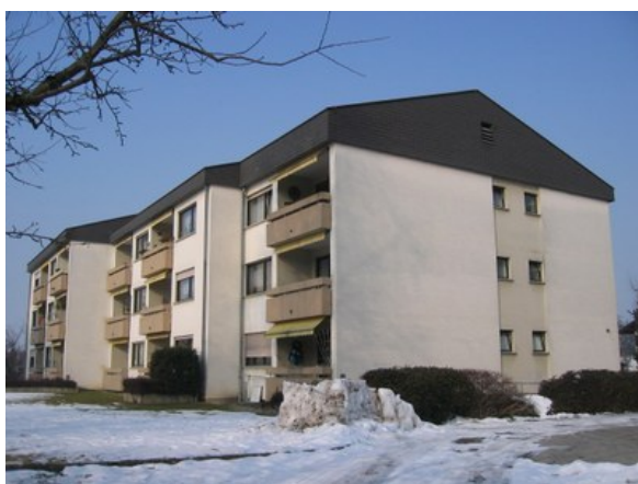
Imagen: Edificio de viviendas Rankweil-Schleipfweg antes de la rehabilitación
