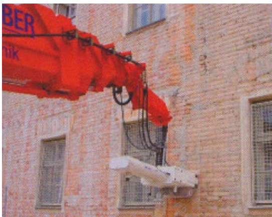
Foto: Fresa en funcionamiento
