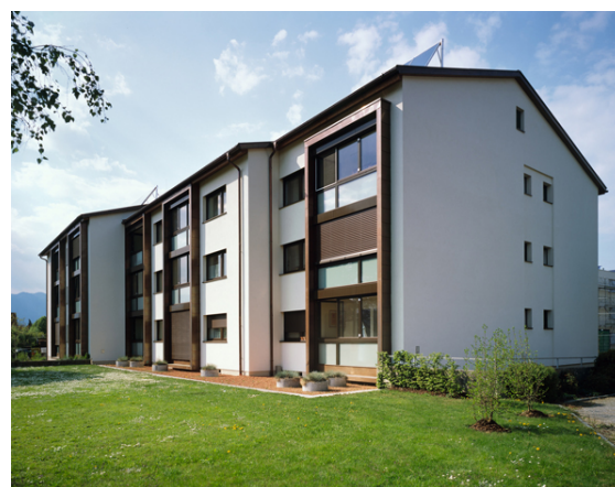
Imagen: Edificio de viviendas Rankweil-Schleipfweg después de la rehabilitación
